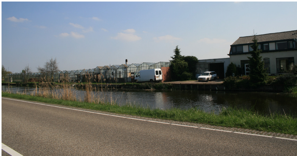
De bebouwing en de kassen langs de Leidsevaart
