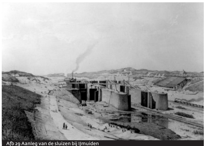
Afb 29 Aanleg van de sluisen bij IJmuiden
